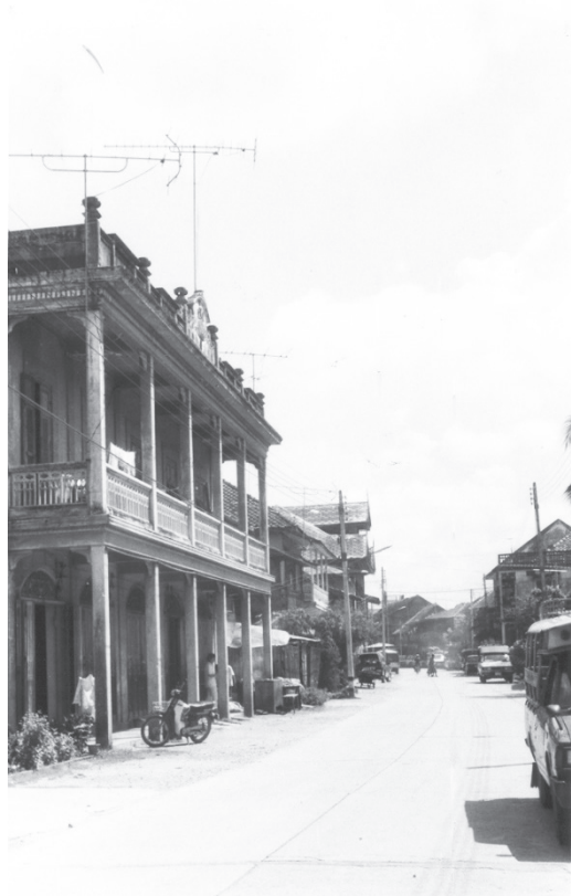
อาคารเก่าบริเวณตลาดจีนลำปาง หรือกาดกองต้าในปัจจุบัน
