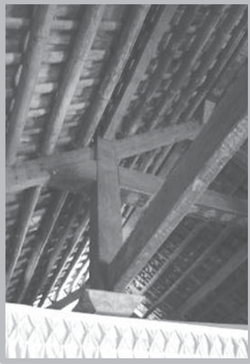
โครงสร้างข้อ แปะ และเครื่องหลังคา
