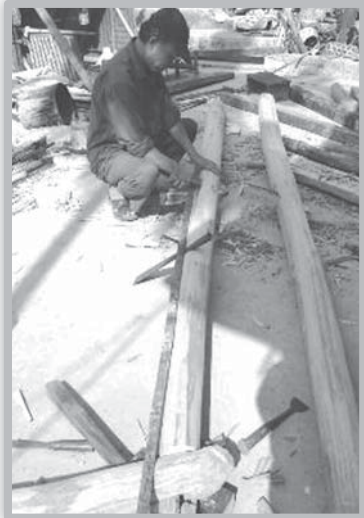
วิธีการสร้างเรือนแบบเข้าไม้ โดยใช้ลิ้ม และเตื่อย
