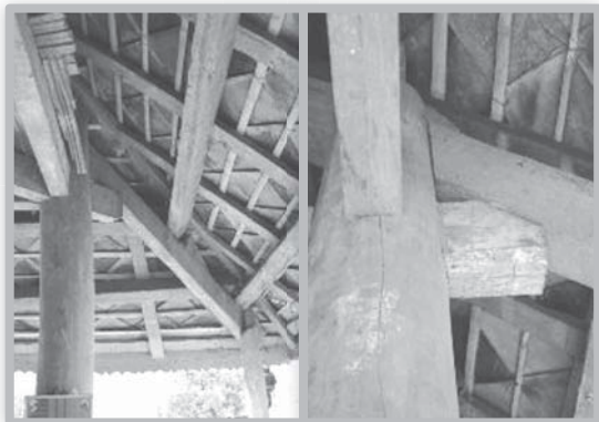
โครงสร้างข้อ แปะ และเครื่องหลังคา
