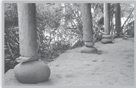
การวางเสาเรือนโดยใช้ก้อนหินเป็นฐาน
